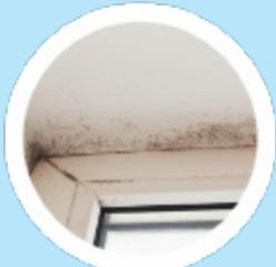
Měření na základě této veličiny využijete u **bazénů**, v **koupelnách** případně u ve **wellness centrech** atd. Nadmerná vlhkost způsobuje plísň, rez a další nežádoucí projevy.
