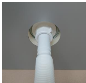
Našroubujete flexi připojení na výpust
