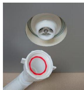
Vložte těsnění do převlečné matice, která je součástí flexi připojení
